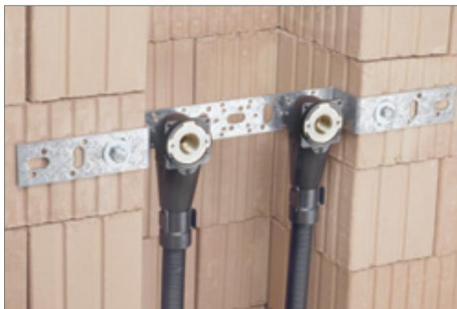
Рис. 6-5 Пример монтажа кронштейна 75/150 для подключения в шахте
