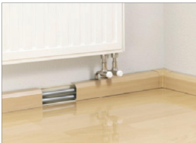
Рис. 4-14 Подключение к радиатору из плинтуса
