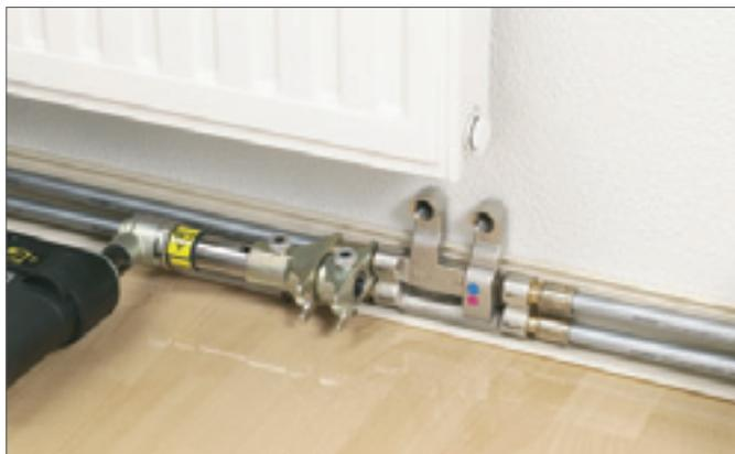
Рис. 18-33 Соединение с помощью подвижной гильзы, трубы  $\varnothing 16$  с крестовиной из комплекта SL- RAUTITAN 16 - 12 - 16
