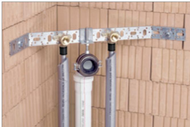
Рис. 6-4 Пример монтажа кронштейна
