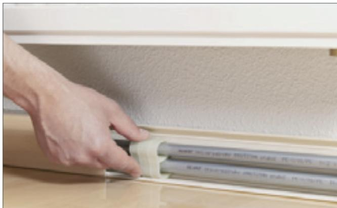
Рис. 18-37 Установка фиксаторов труб отопительной разводки
