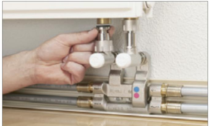
Рис. 18-26 Подключение угловых телескопических резьбозажимных соединений
