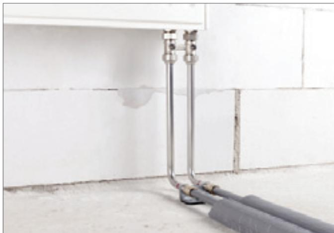
Рис. 4-12 Подключение к радиатору из пола
