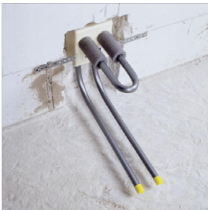
Рис. 4-13 Подключение к радиатору из стены
