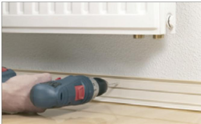
Рис. 18-31 Закрепление основания плинтусного канала RAUSOLO
