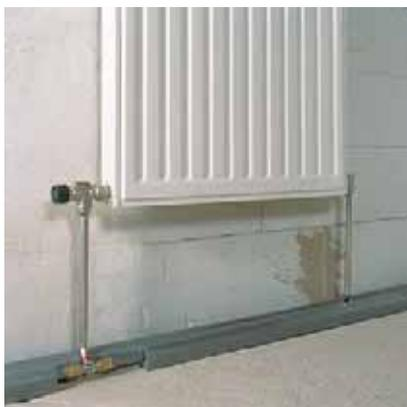
Рис. 144. Разностороннее присоединение с помощью Т-образных присоединительных трубок
