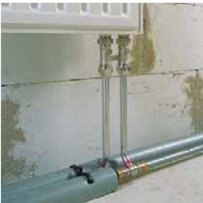
Рис. 131. Присоединение отопительных приборов в двухтрубной кольцевой тупиковой горизонтальной системе отопления
