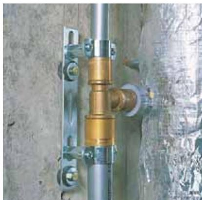
Рис. 99. Формирование точки неподвижного крепления с помощью монтажной скобы с хомутами
