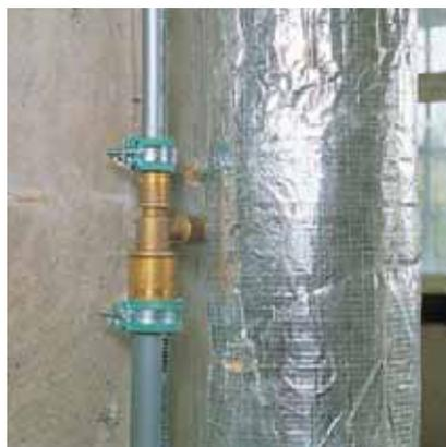
Рис. 100. Формирование точки неподвижного крепления с помощью двух хомутов
