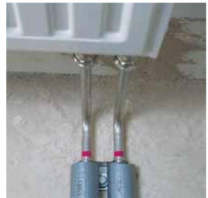
Рис. 133. Г-образные соединительные трубки для подключения к последнему отопительному прибору
