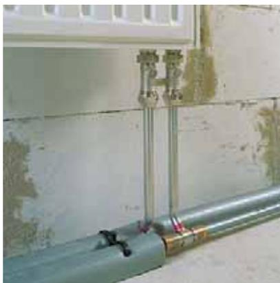
Рис. 143. Подключение отопительного прибора со встроенным блоком шаровых кранов с помощью Т-образной присоединительной трубки
