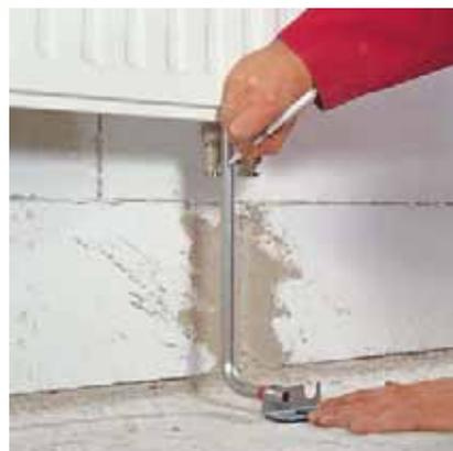
Рис. 136. Отмерить длину присоединительной трубки
