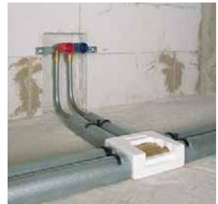
Рис. 154. Готовый узел присоединения к отопительному прибору с помощью настенных угольников
