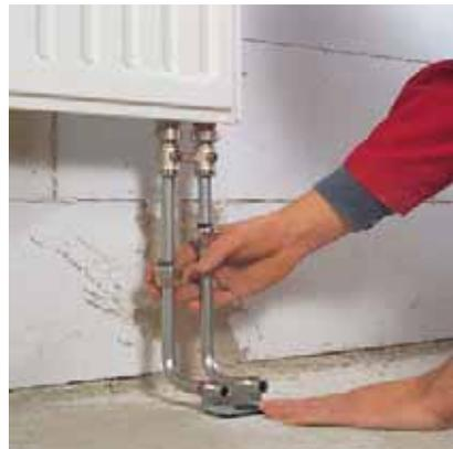
Рис. 138. Надвинуть резьбозажимные соединения на присоединительные трубки
