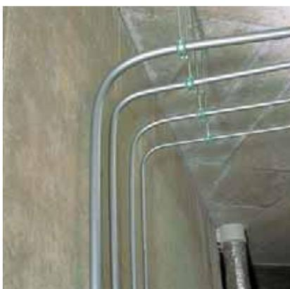
Рис. 116. Стояки, изогнутые под потолком из труб RAUTITAN stabil
