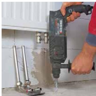
Рис. 140. Просверлить отверстие под дюбель
