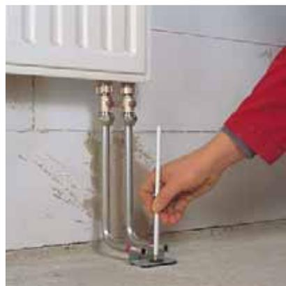
Рис. 139. Отметить место крепления фиксирующего уголка
