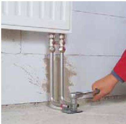
Рис. 141. Крепление фиксирующего уголка
