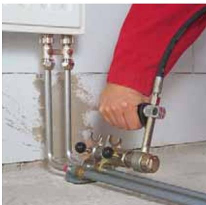
Рис. 142. Присоединить полимерные трубы с помощью подвижной гильзы
