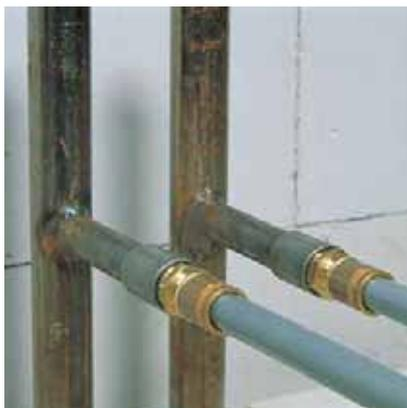
Рис. 73. Переход с труб RAUTITAN на стальные трубопроводы
