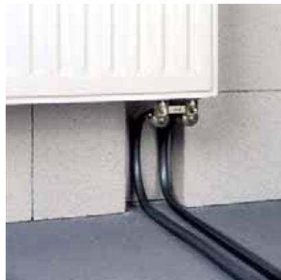
Рис. 152. Непосредственное подключение труб RAUTITAN stabil к блоку шаровых кранов
