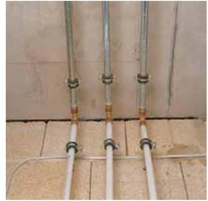
Рис. 125. Магистраль в подвале. Переход из вертикального в горизонтальное положение с помощью труб RAUTITAN his
