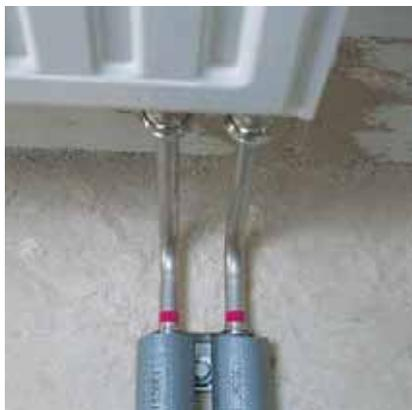
Рис. 135. Подключение к отопительному прибору „из пола“ с помощью Г-образных присоединительных трубок
