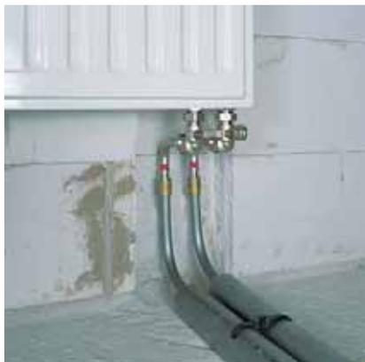
Рис. 150. Подключение к отопительному прибору труб RAUTITAN stabil с помощью Г-образных соединительных трубок
