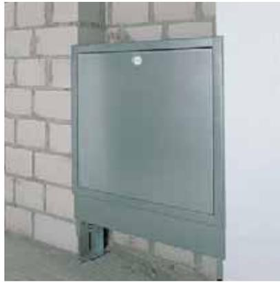
Рис. 162. Вариант встроенного распределительного шкафа
