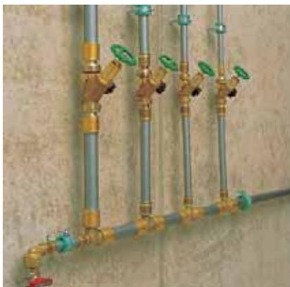
Рис. 114. Система холодного водоснабжения из труб RAUTITAN stabil
