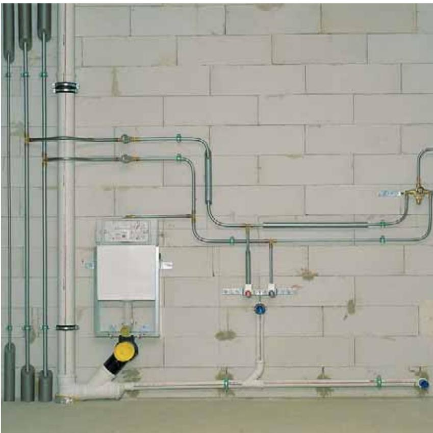
Рис. 118. Поэтажное ответвление стояков из труб RAUTITAN stabil
