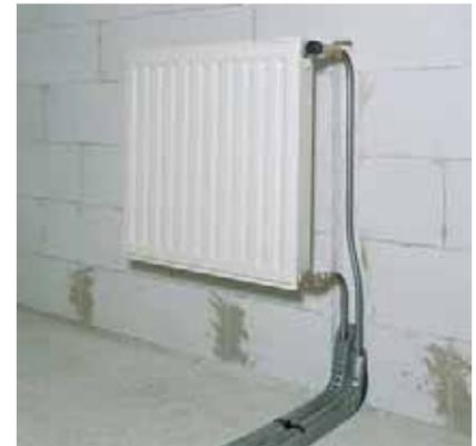
Рис. 153. Непосредственное подключение к вентилям отопительного прибора
