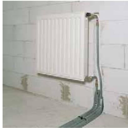
Рис. 151. Боковое подключение к отопительному прибору
