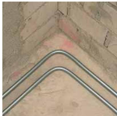
Рис. 132. Исполнение отводов трубами RAUTITAN stabil
