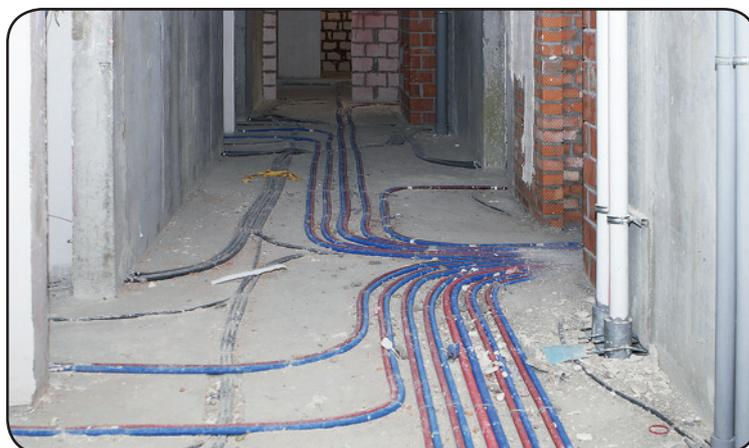
по таким параметрам, как долговечность (срок службы труб и соединений при соблюдении рабочих характеристик не менее 50 лет) и надежность соединений труба-фитинг (возможность скрытой прокладки).
