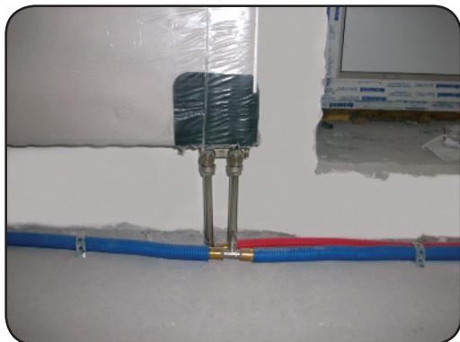
2. Трубка (Т или L-образная) Sanext для подключения к радиатору и фитинг подключения L и T-образной медной трубки - D15 - G 1/2»
