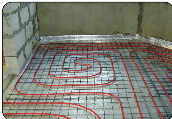
Конструктивно система SANEXT «Теплый пол» состоит из источника теплоносителя (центральное отопление, индивидуальный тепловой пункт, котел на любом виде топлива и т.п.), подводящих труб, распределительных и сборных коллекторов и собственно труб SANEXT «Теплый пол», укладываемых в пол и подсоединяемых к коллекторам.
